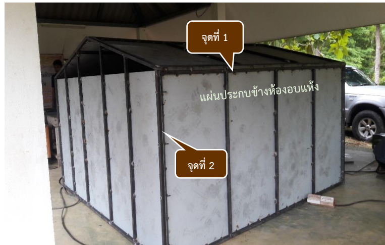
ภาพที่ 3 ลักษณะการเชื่อมประกอบแผ่นประกบข้างห้องอบแห้ง
